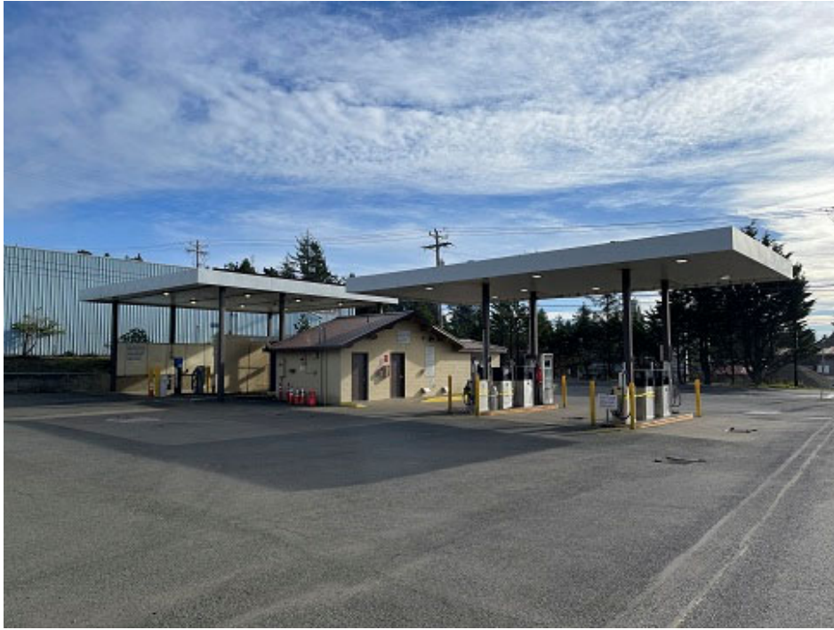
817 NE 3 rd Street – SE View
